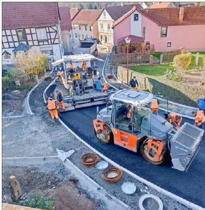
Der Ausbau der Ortsdurchfahrt ging 2022 ein gutes Stück voran
