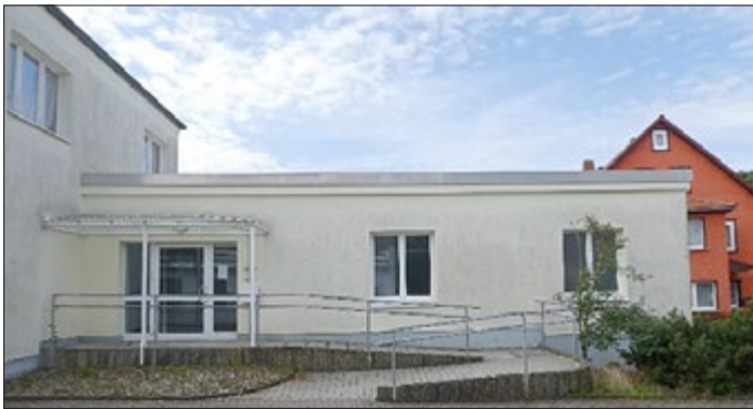
Teilansicht Anbau mit behindertengerechtem Zugang
